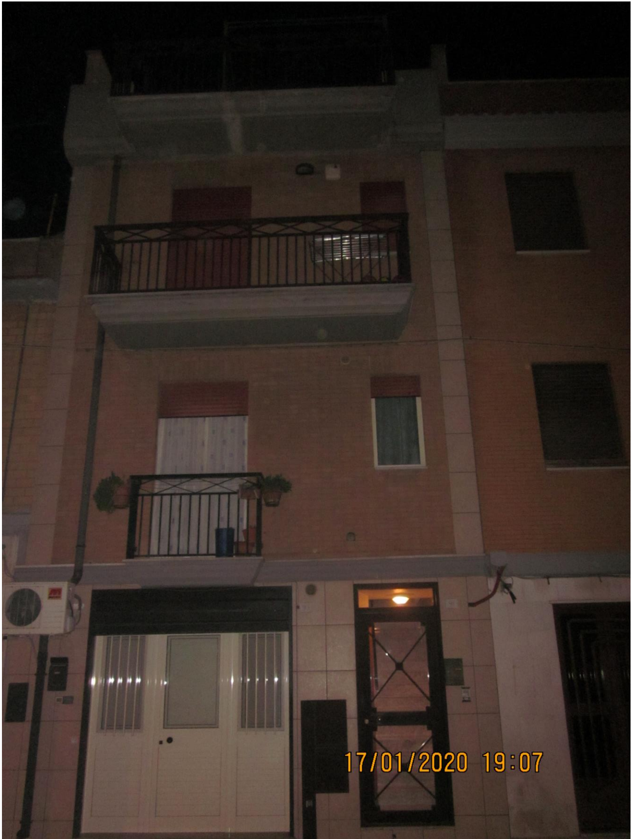
FOTO N. 1. Facciata esterna immobile
