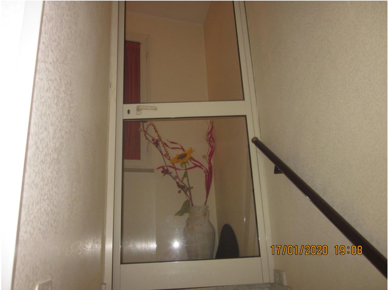
FOTO N. 4. Porta d'ingresso al disimpegno del piano 2
