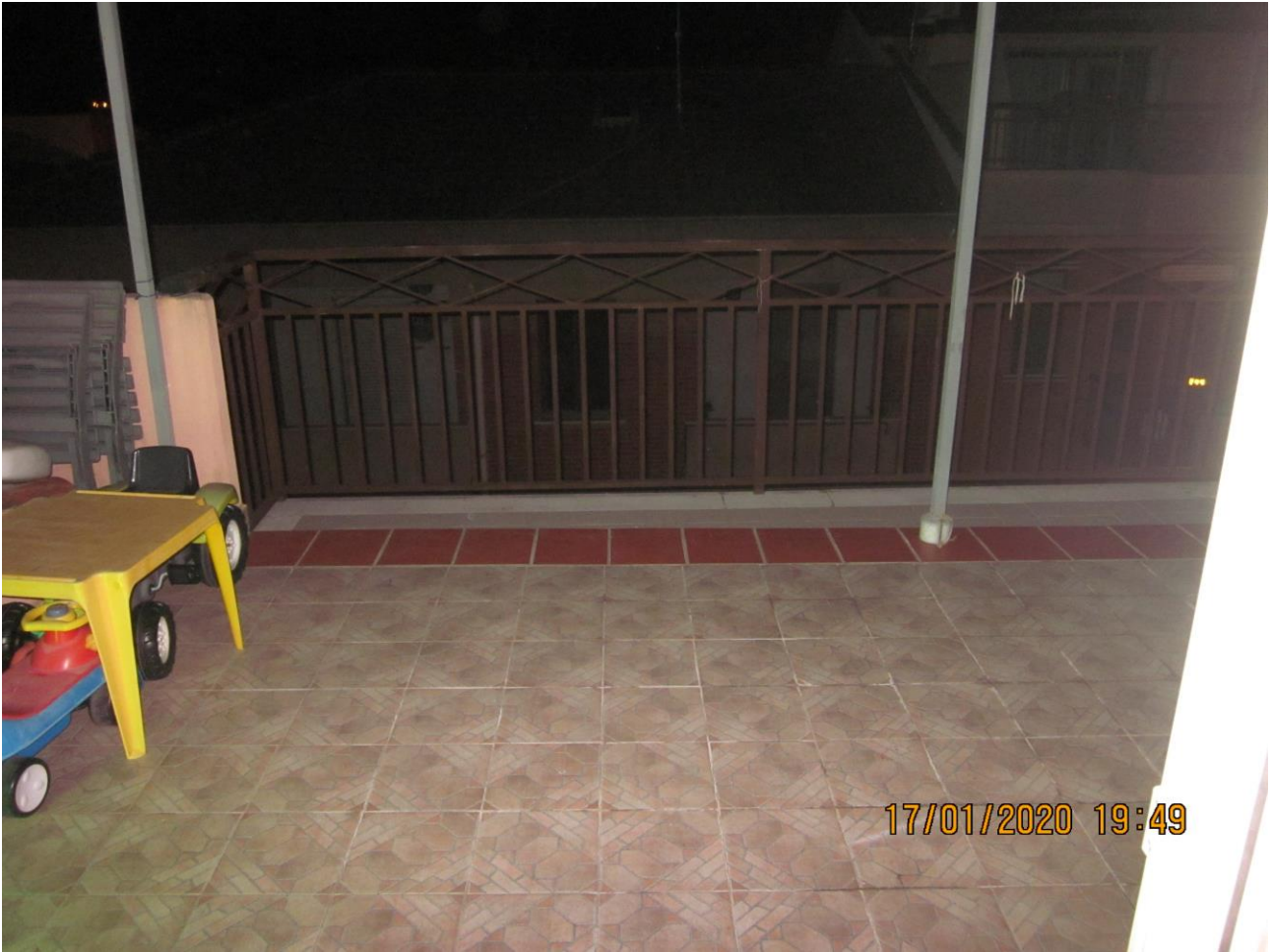
FOTO N. 11. Terrazzo al piano 3
